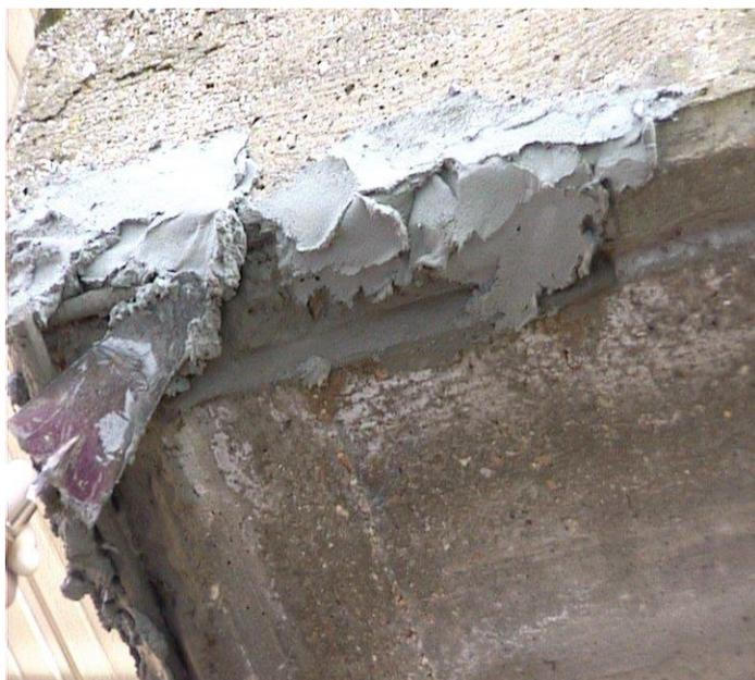
Aspect final d'un mortier de réparation formulée avec le **Pentamix IT.1**
